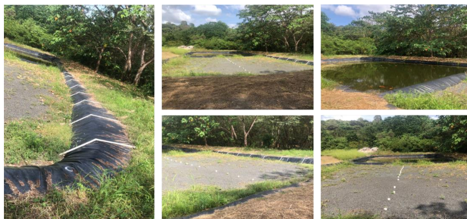
Ilustración 7 Vistas de las celdas de disposición de residuos en vertedero de Pedasí.
