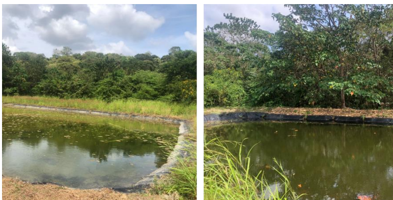
Ilustración 8 Celdas inundadas en vertedero de Pedasí.
